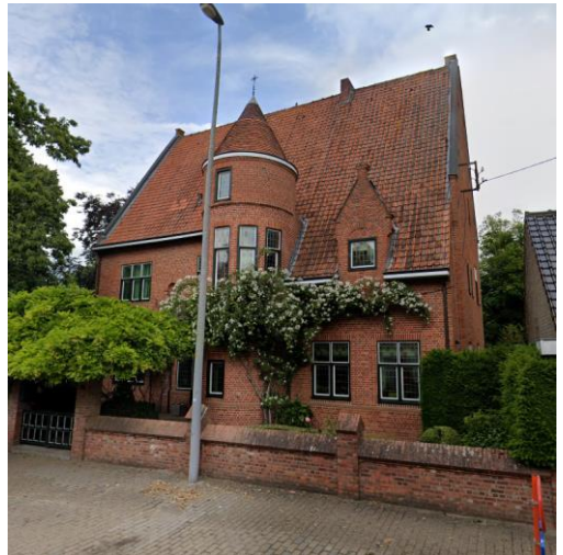
Foto 4: Voormalige pastorie in een ommuurde tuin
